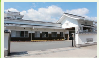
特別養護老人ホーム 城辺みしま荘 年間45.3%の温室効果ガスを削減し、年間約440万円の経費が削減されました。
