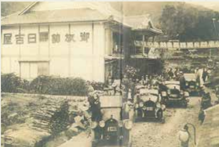
日吉屋（現：日吉支所駐車場）昭和4年撮影 鬼北町所蔵
